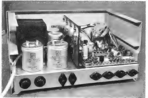
Bild 6. Innenansicht des Verstärkers
