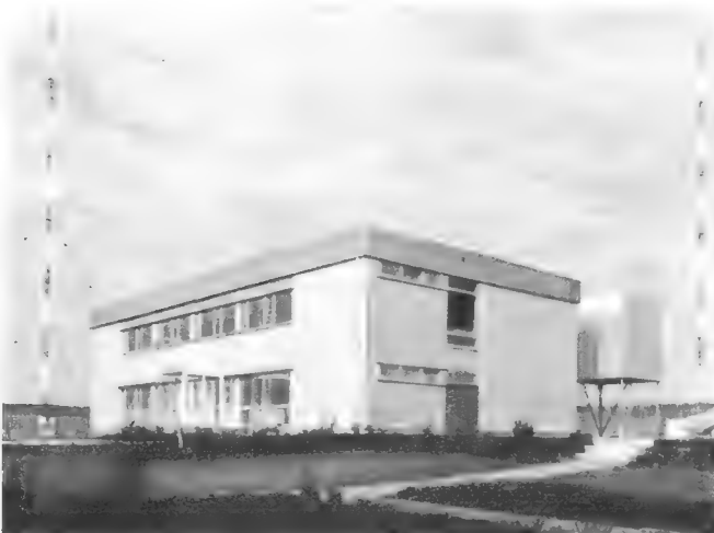
Bild 2. Das Senderhaus mit einem Kühlturm und zwei Masten im Hintergrund
